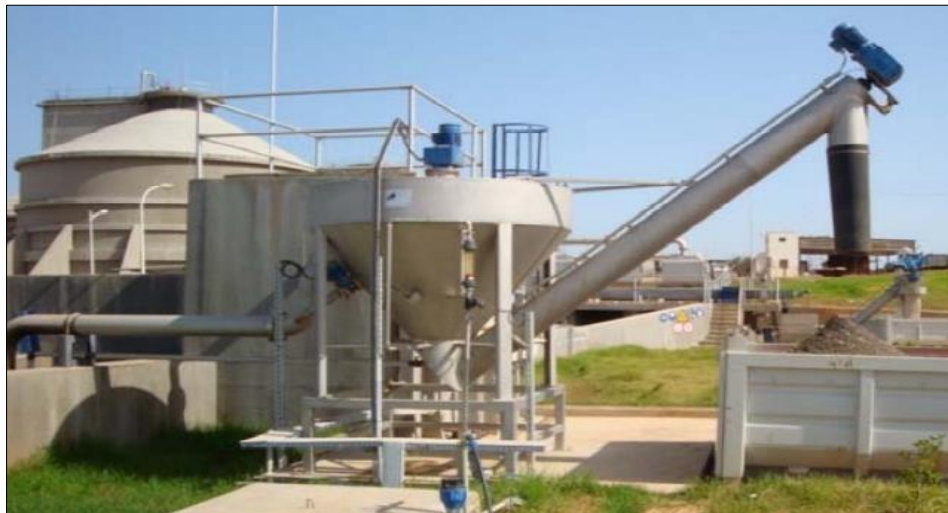
Figure III.2 : Classificateur et laveur de sables( Source :STEP BOUFARIK)
