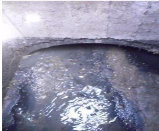
**Figure II-5 : collecteur complètement bouché et dégradé.**
