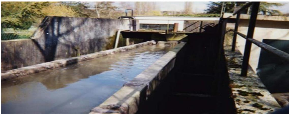
Figure VII-5 : Exemple de déversoir à double seuil.
