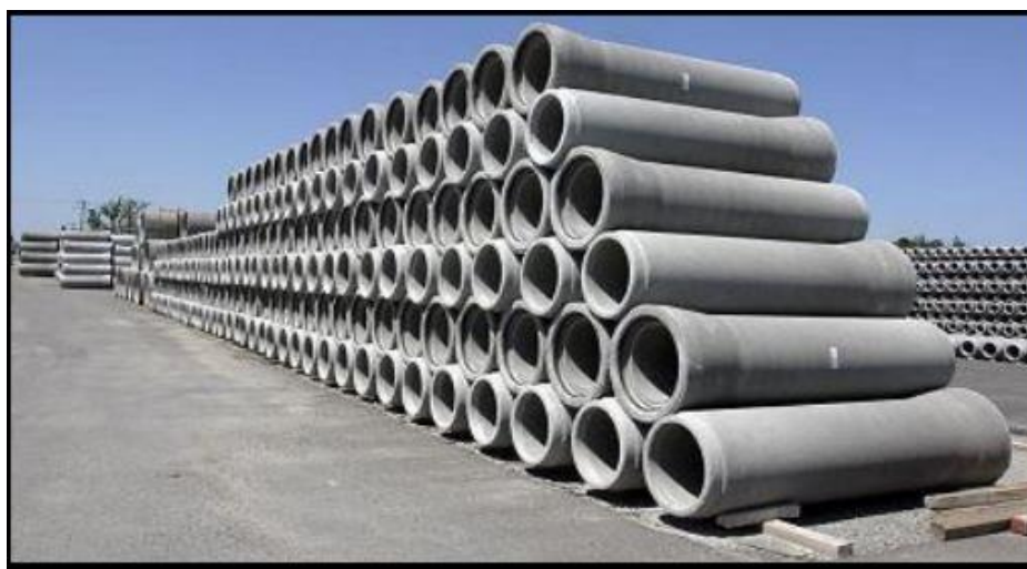
Figure VII-1 : Stockage déchargement des canalisations.
