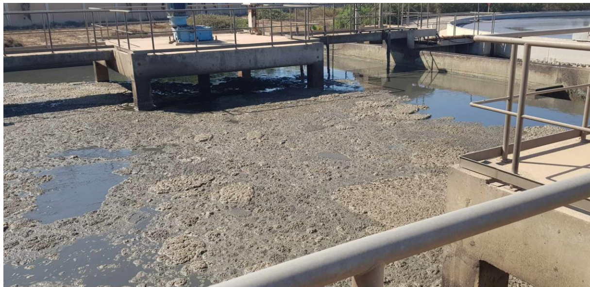
Figure III.11 : La zone de dégazage
