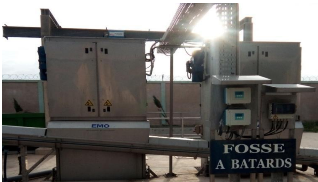
Figure III.5 : Dégrillage grossier
