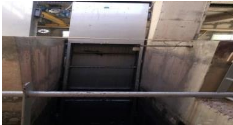
Figure III. 10 : Un dégrillage grossier.
