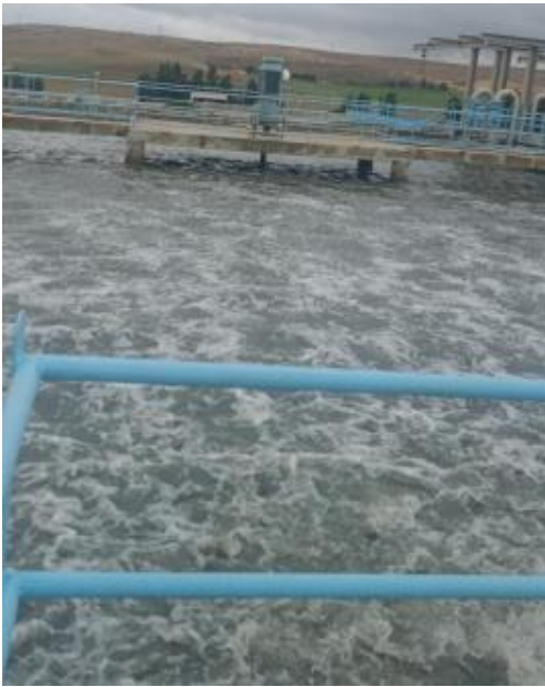
Figure III. 15 : Bassin d'aération.
