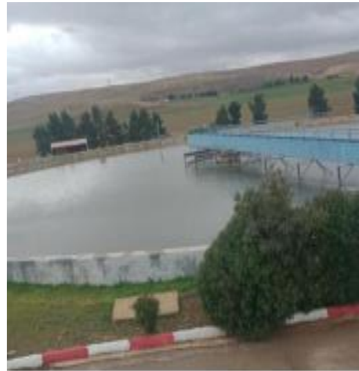
Figure III. 17 : Décanteur secondaire.
