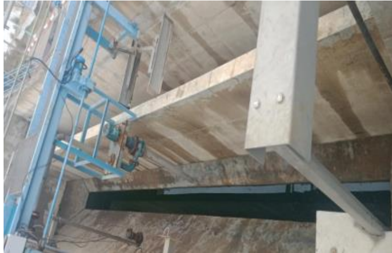
Figure III. 13 : Dessableur/Dégraisseur.
