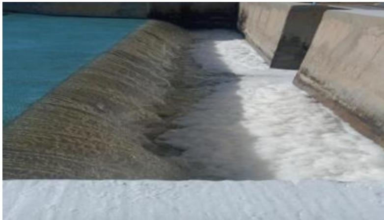
Figure IV. 5 : Photos des mousses dans les eaux épurées.
