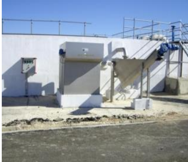
Figure III. 14 : Classificateur à sable/Concentration graisses.
