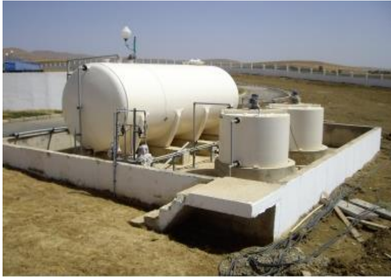
Figure III. 18 : Réservoir de chloration.
