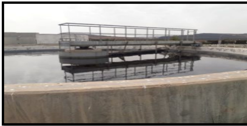
Figure IV.7: Décanteur secondaire
