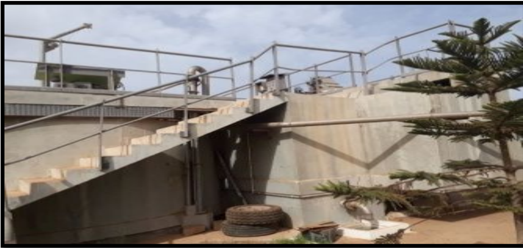
FigureIV.4: Bassin de dégraissage-dessablage
