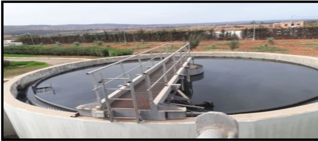
Figure IV.5: Décanteur primaire circulaire
