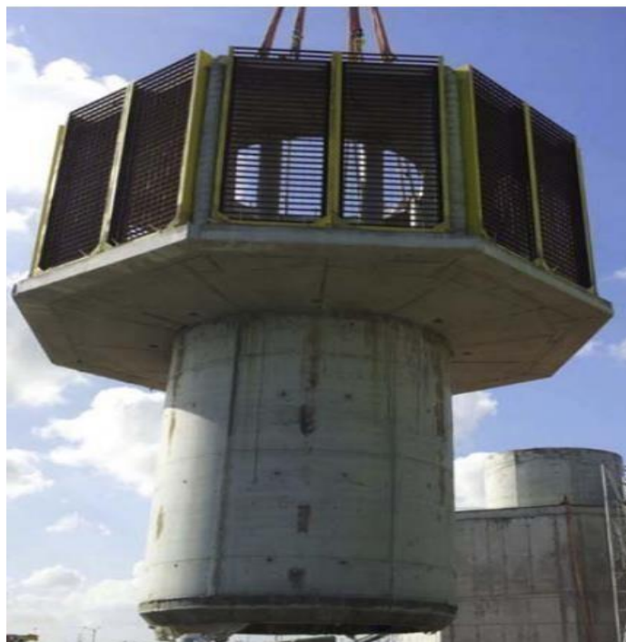
Figure III.1. Tour d'aspiration verticale avec tamis grossier
