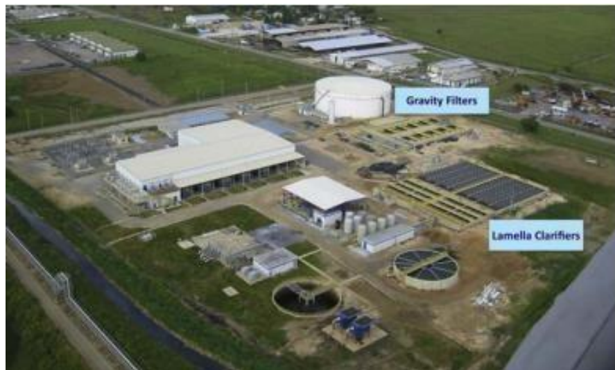
Figure III.6. Usine de dessalement de Trinidad
