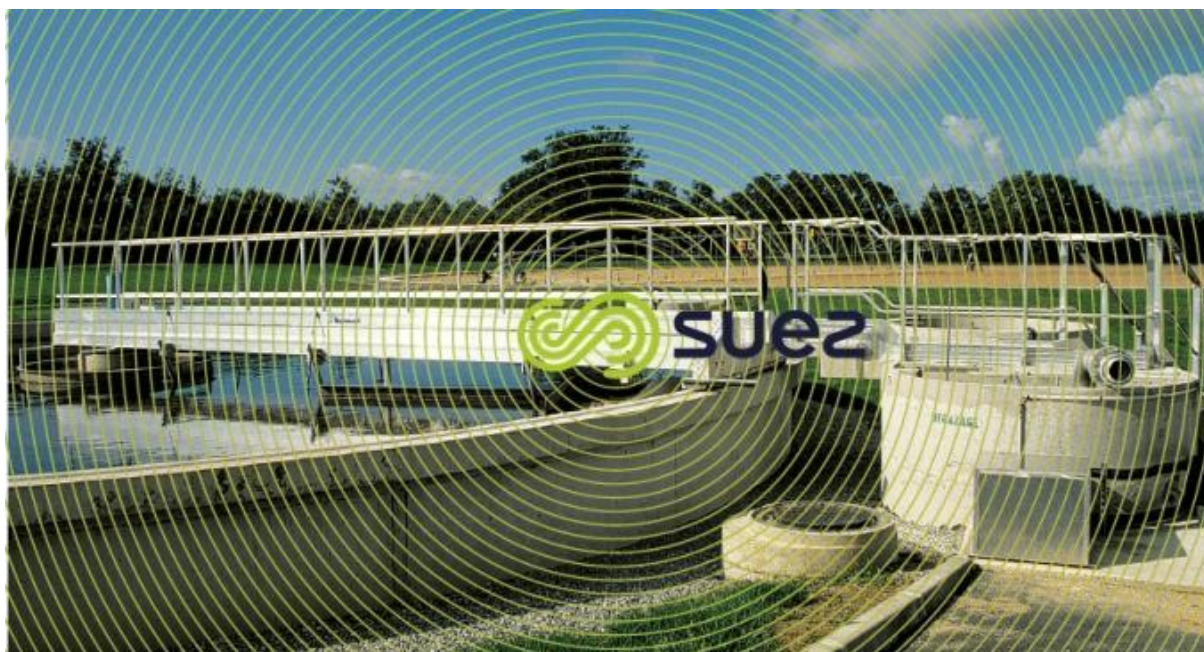
Fig. 2.3- décanteur circulaire avec raclage des boues.[10]
