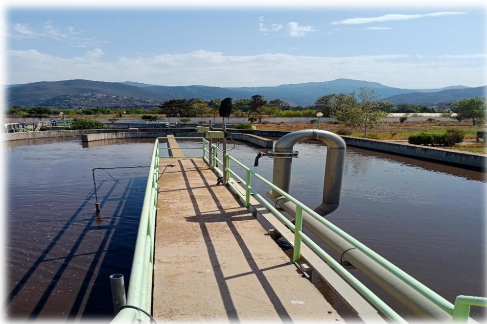
Figure III. 6: le décanteur de la station d'épuration de Sidi ALI Lebher
