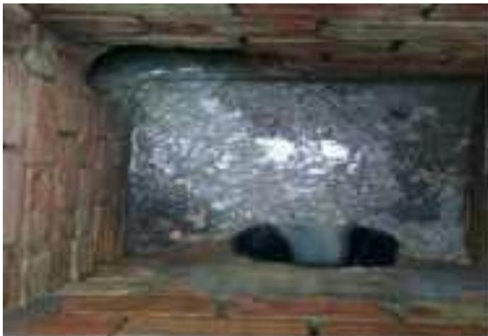
Figure II5: Regard dont la conduite aval est masquée par les dépôts
