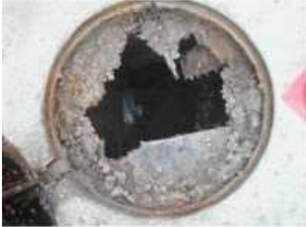
Figure II4: Regard colmaté dont les conduites amont et aval sont masquées. On remarquera la dégradation du génie civil du regard
