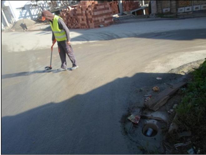
Figure II6: portion de rue sans regard localisé malgré les appareils de détection employés
