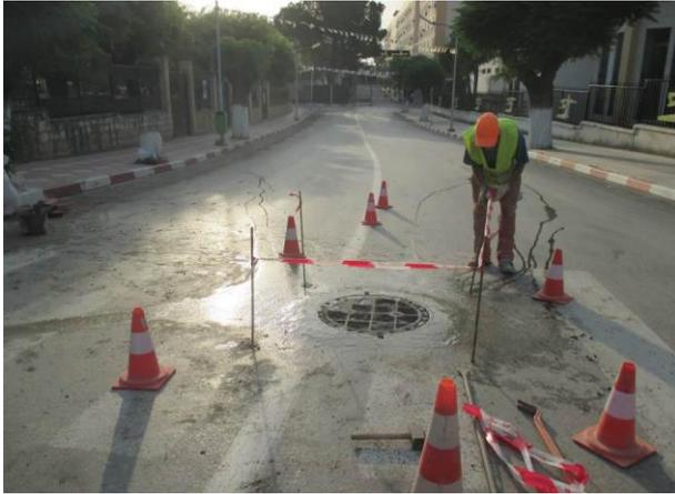
Figure II10: Travaux de rehausse
