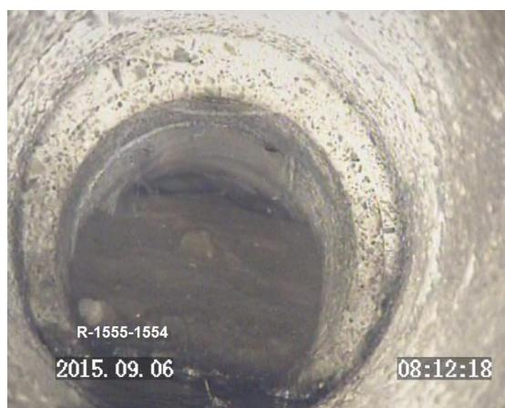
Figure II2: inspection par caméra ( un obstacle qui bouche complètement le collecteur )
