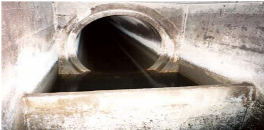
Figure VI-8 : Exemples de déversoir frontal
