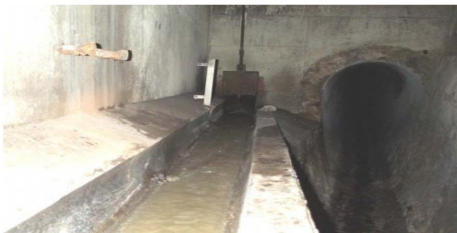
Figure VI-9 : Exemple de déversoir à seuil latéral
