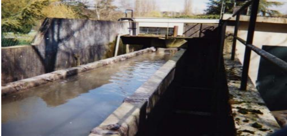
Figure VI-10 : Exemple de déversoir à double seuil
