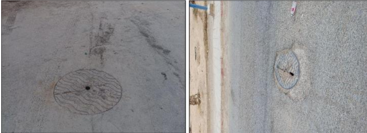
Figure III.7 : Tampons dégradés
