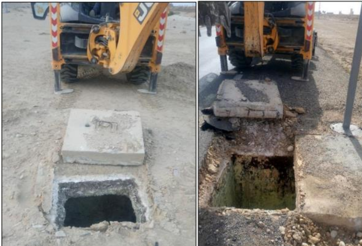
Figure III.8 : Couverture des regards avec des dalles lourdes
