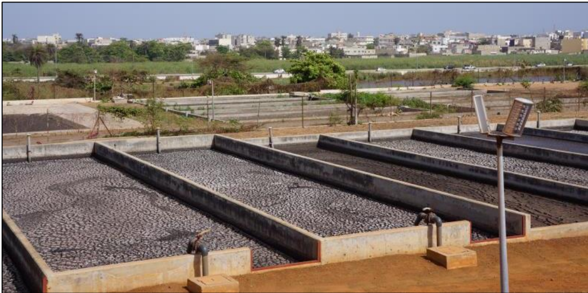
Figure. V.4: Lits de séchage non plantés dans une station de traitement des boues de vidange à Dakar, Sénégal (Source : Eawag-Sandec)
