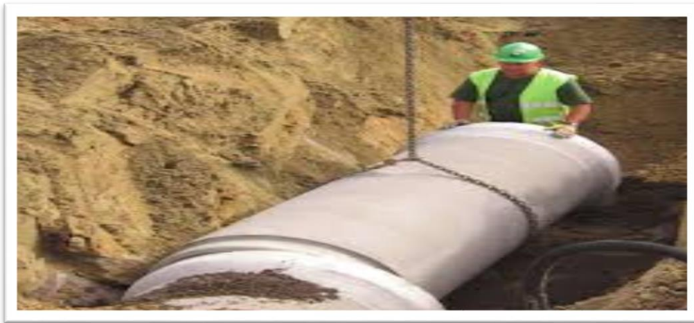
Figure (VII- 3) : assemblage des tuyaux en béton
