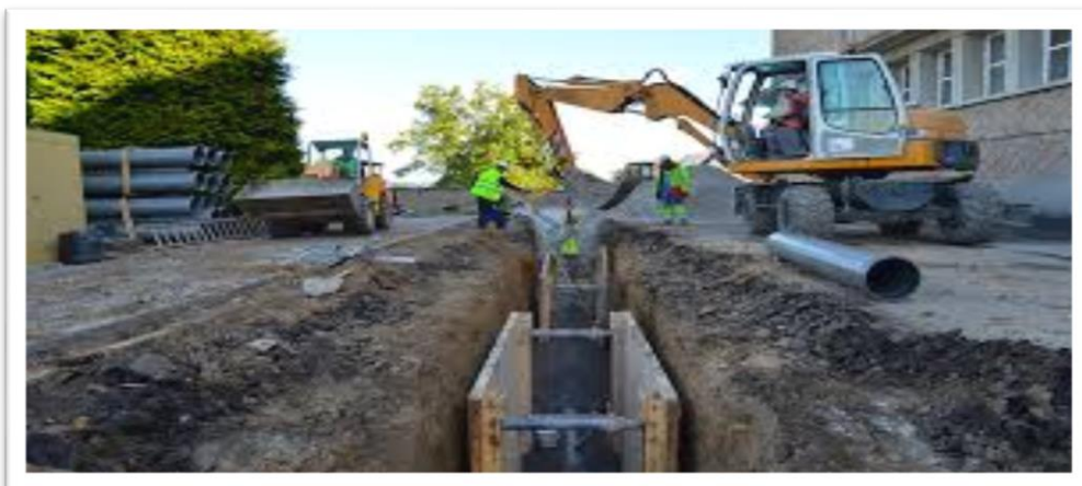
Figure (VII- 2) : Pose de la canalisation
