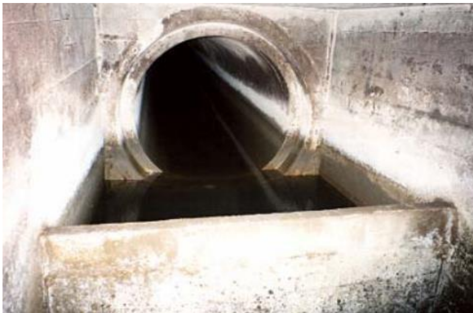
Figure (VI- 5) : type de déversoir by pas
