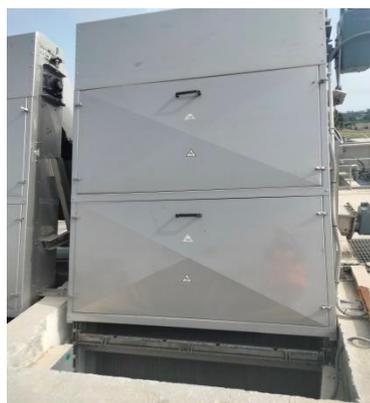
**Figure 6 :** dégrillage fin
