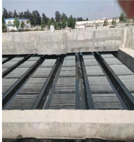
**Figure 8 : décanteur lamellaire**
