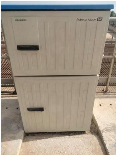
**Figure 3:** échantillonneur
