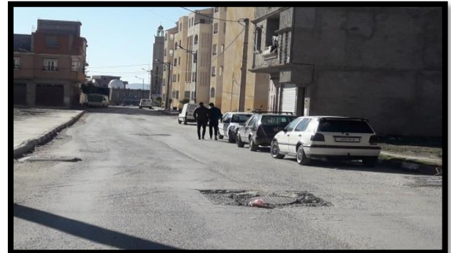
Figure II. 7: Tampon de regard élevé et dégradé par rapport à la route.
