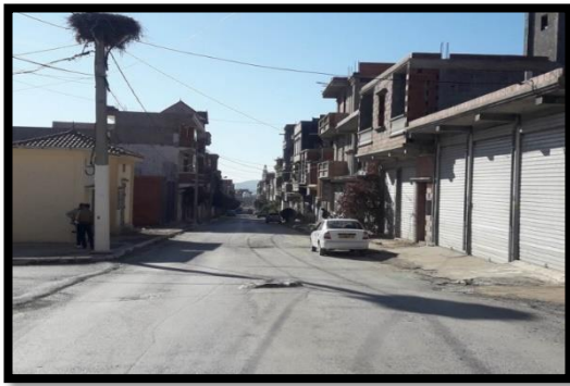
Figure II. 7: Tampon de regard élevé et dégradé par rapport à la route.
