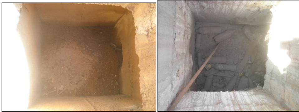
Figure III-3 : regards sans écoulement et avec déblai
