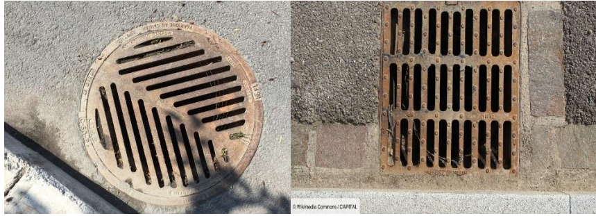
Figure VI-2 : bouches d'égout de type " à pénétration par le haut "
