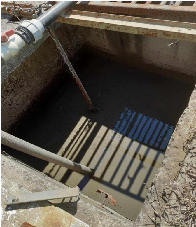
Figure 7: le bassin de recirculation
