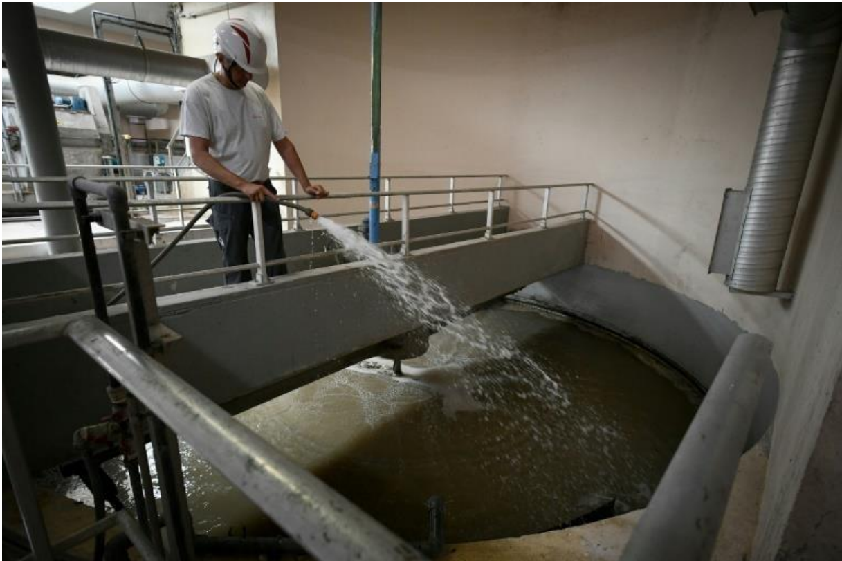
Figure 20: Ouvrier qui nettoie un bassin d'une STEP
