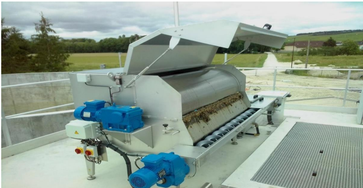
Figure 12: Principe de fonctionnement d'un tami
