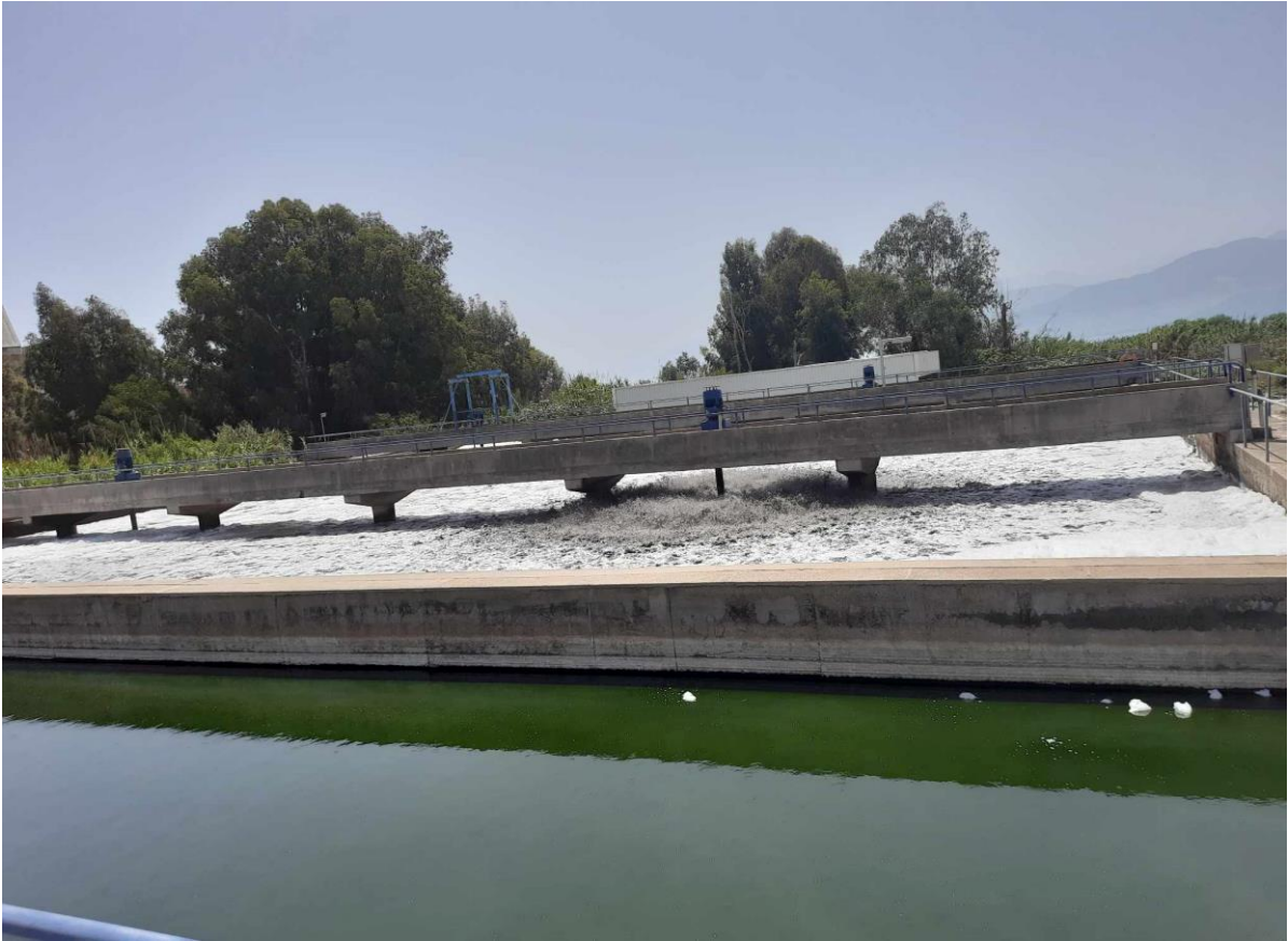
Figure 8: Bassin d'aération
