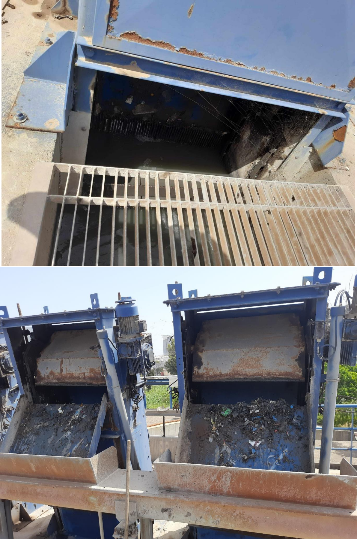
Figure 6 : Dégrilleur fin
