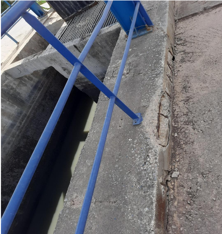
Figure 4: fosse à batard et dégrilleur
