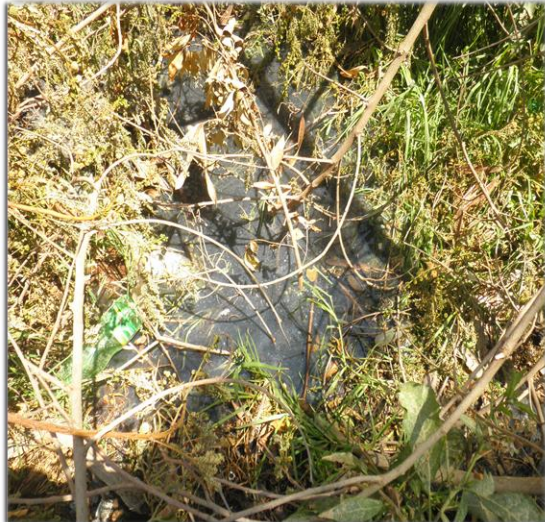
Figure II-04 : Débordement de regard au niveau du cite les Annassers 1 (01-06-2016)
