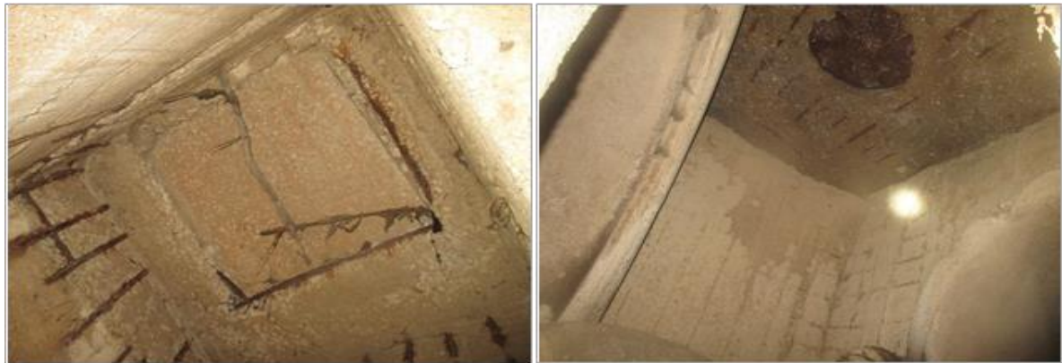
Figure V-5 : Repérage des regards enterrés « inspection pédestre » (2020)
