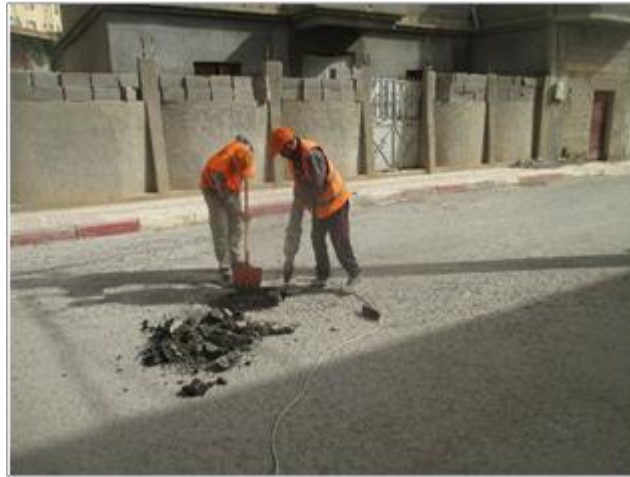
FigureV-2 : Travaux débitumage des regards pour inspection (Tampon circulaire)(2020).
