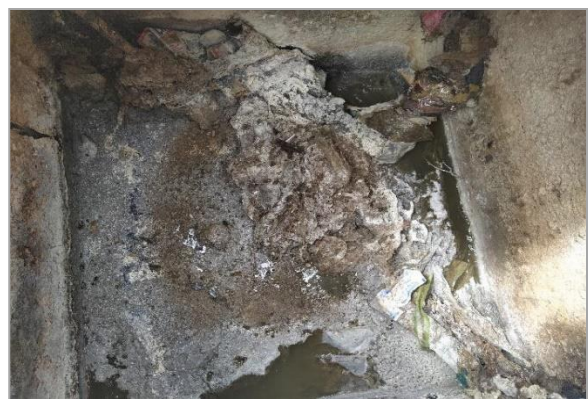
Figure V-3 : Travaux débitumage des regards pour inspection (dalles de béton armé)(2020).
