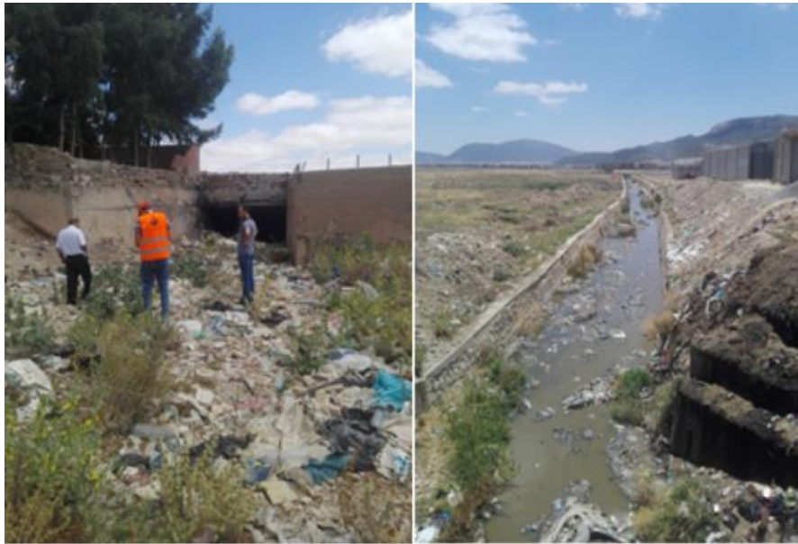
Figure I-9 : Amont et Aval de la galerie d'Oued Zaarour (2021)
