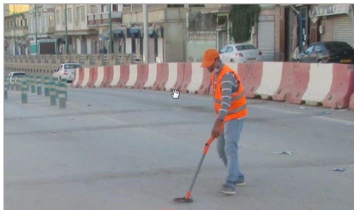
Figure V-1 : Travaux de détection des regards.(2020)
