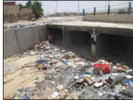
Figure I-16 : Aménagement d'Oued Anba coté STEP (2021)
