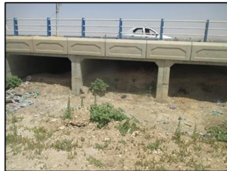
Figure I- 14 : Canal sur l'Oued coté gare routière (2021)
