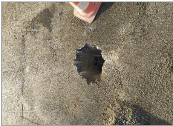
Figure V-3 : Travaux débitumage des regards pour inspection (dalles de béton armé)(2020).
