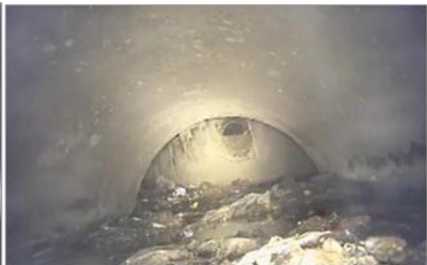
Figure V-4 : Repérage des regards enterrés par la caméra (2020)
