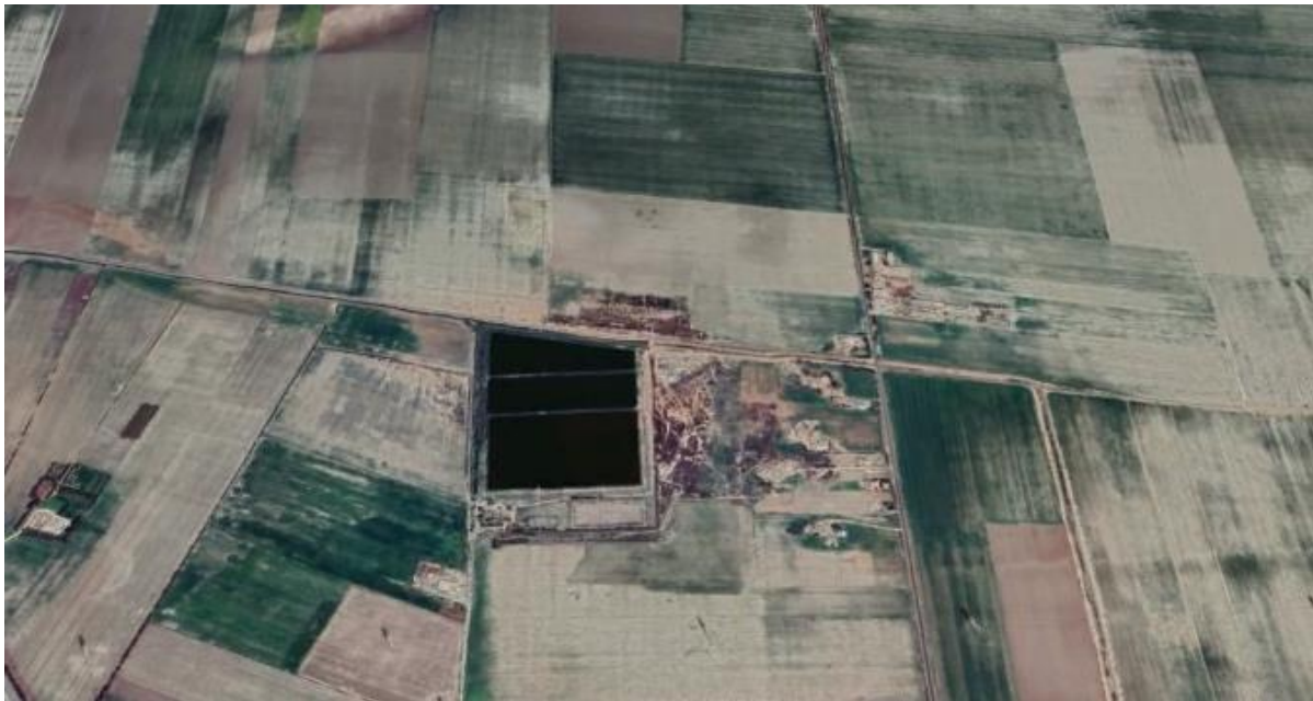
Figure II.4 : vue aérienne de la station de lagunage.
