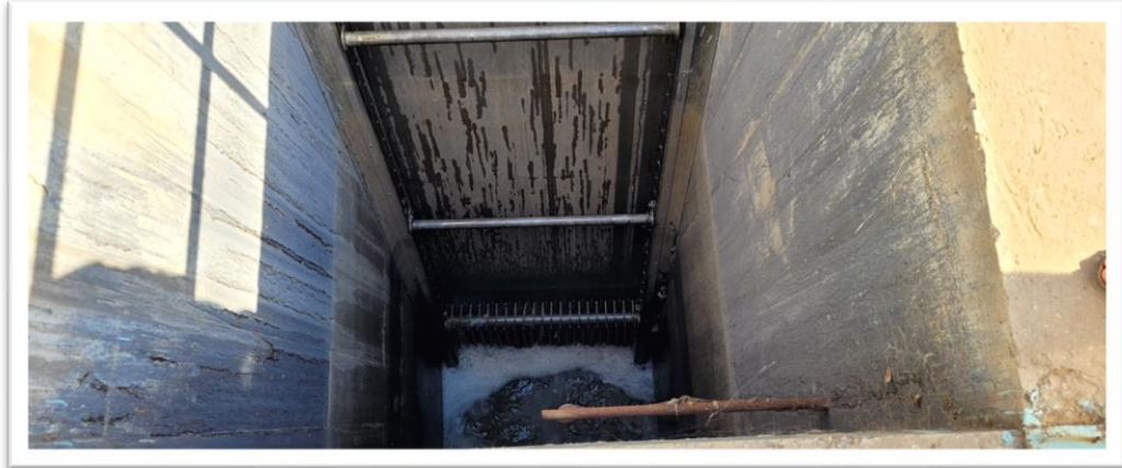
Figure II.2: un dégrilleur grossier
