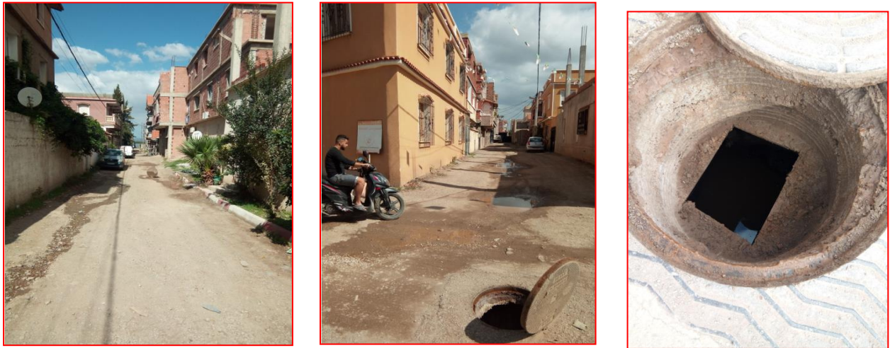
Figure II-2 : Photos générales sur l'ouverture des regards (prises le 25/07/2023).
