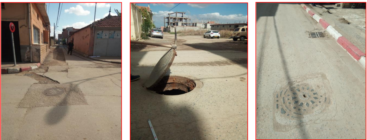
Figure II-1 : Photos générales sur l'ouverture des regards (prises le 25/07/2023).
