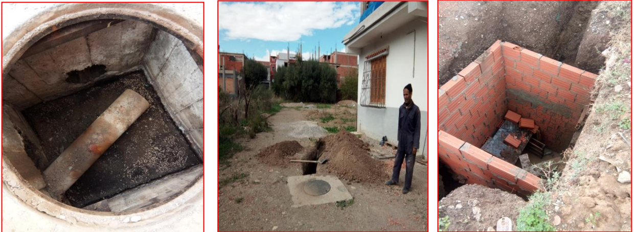
Figure II-5 : Photos générales sur l'ouverture des regards avec les mesures nécessaires.
