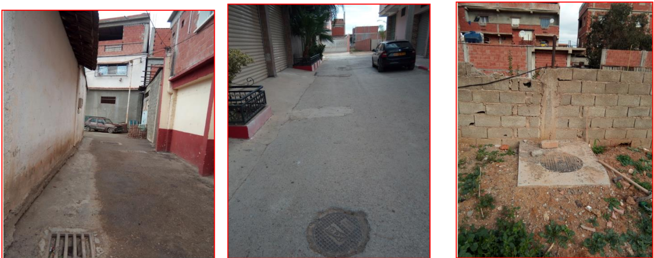
Figure II-4 : Photos générales sur l'ouverture des regards (prises le 25/07/2023).
