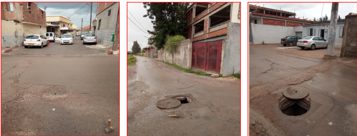
Figure II-3 : Photos générales sur l'ouverture des regards (prises le 25/07/2023).
