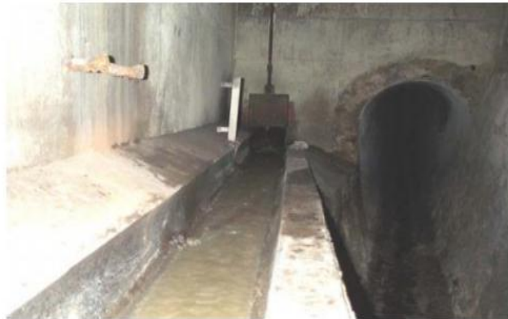
Figure VII.10 : Exemple d'un déversoir d'orage à seuil latéral
