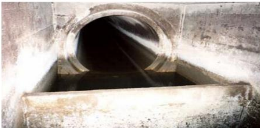
Figure VII.08: Exemple d'un Déversoir d'orage à seuil frontal
