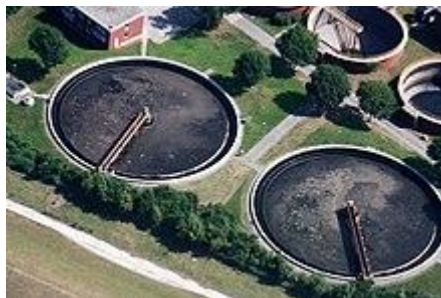
Vue aérienne de clarificateurs. (source : google)
