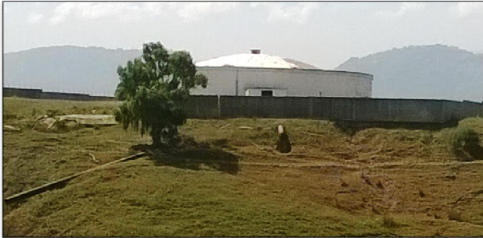
.Figure I.7: Le réservoir de capacité 5000m 3 (Bureau d'étude CNERU)
