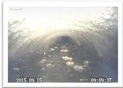
Une image en caméra endoscopique montrant un collecteur partiellement colmaté. Le collecteur est rempli d'eau et de boue, réduisant considérablement la section libre. Des informations techniques sont superposées en bas de l'image : '2015. 09. 15' et '09:09:37'.                                                     |
