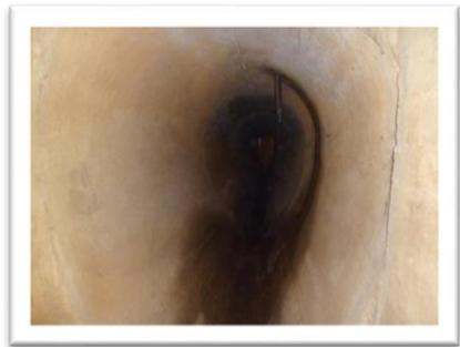
Une image en caméra endoscopique montrant un branchement individuel direct sur un ovoïde. Le collecteur principal est en béton et le branchement est une conduite plus petite qui se jette directement dans le collecteur. Des informations techniques sont superposées en bas de l'image : '2015. 09. 15' et '09:09:37'. |
