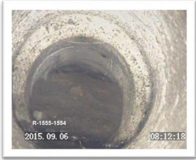
Une image en caméra endoscopique montrant un collecteur d'égout complètement bloqué par un obstacle circulaire et dur. Le collecteur est en béton et l'obstacle occupe toute la section. Des informations techniques sont superposées en bas de l'image : 'R-1555-1554', '2015. 09. 06' et '08:12:18'.                     |
