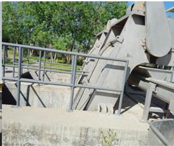
Figure III.3 : dégrilleur fin
