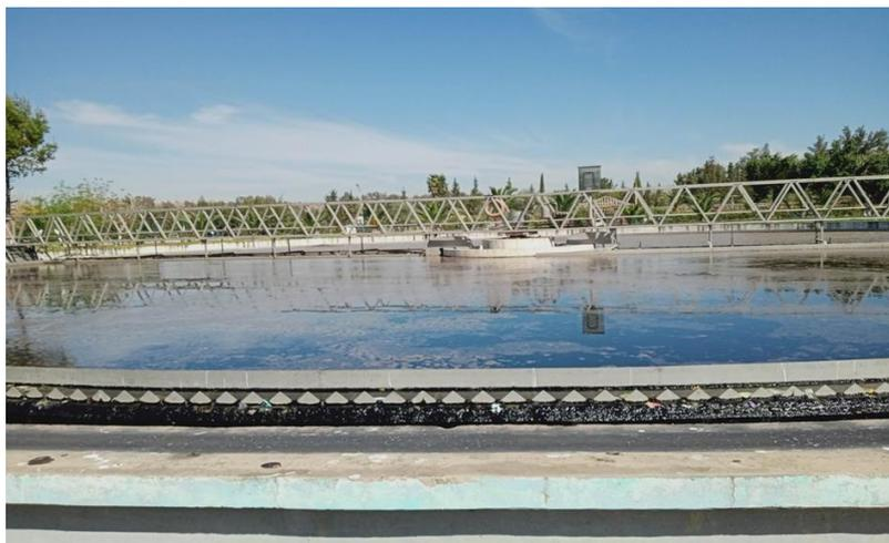
Figure III.6 : Décanteur secondaire
