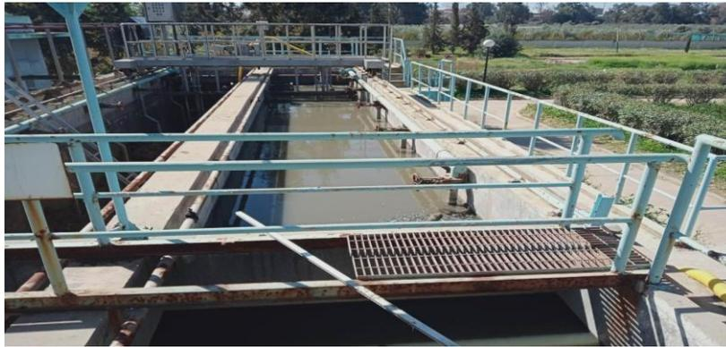
Figure III.4 : Dessablage-dégraissage
