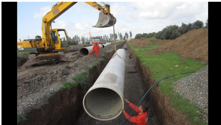
Figure VIII-2 : Pose de la canalisation
