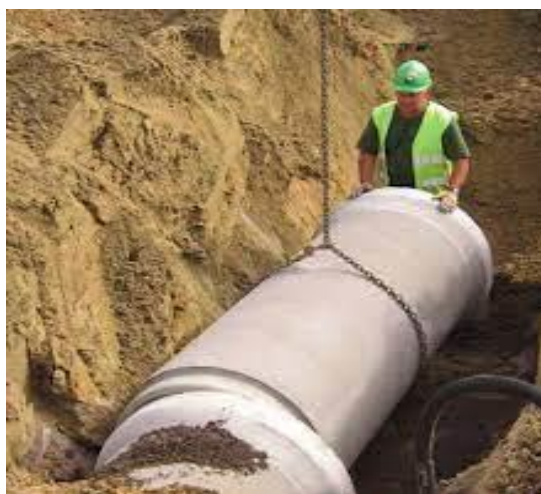
Figure VII-3 : assemblage des tuyaux en béton
