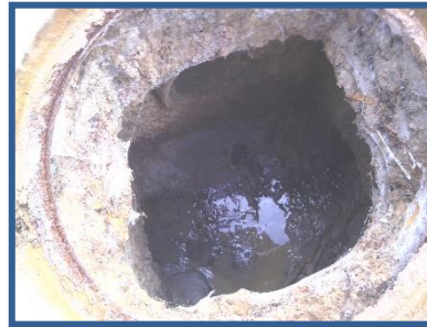
Figure 2 Regard de chute après décoffrage
