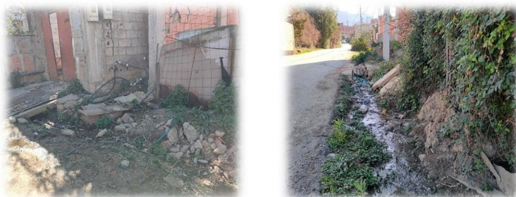
**Figure I-5 : Débordement des fosses septicques provoquant un ruissellement des eaux usées (Source : BET ETH)**
