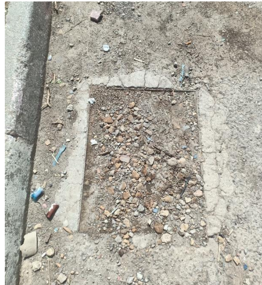
Figure II.6 : représente l'état des bouches d'égout
