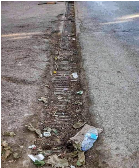
Figure II.6 : représente l'état des bouches d'égout
