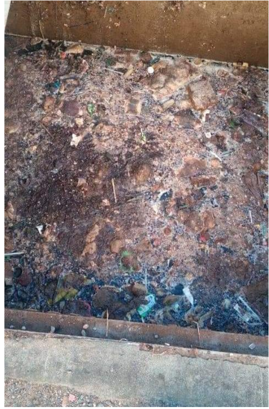
Figure II.1 : Colmatage des regards (Besoin de curage)
