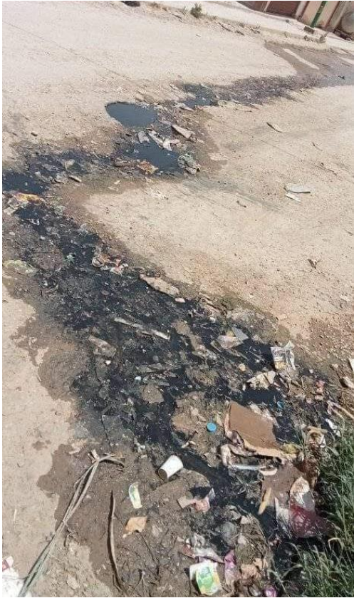
Figure II.1 : Colmatage des regards (Besoin de curage)
