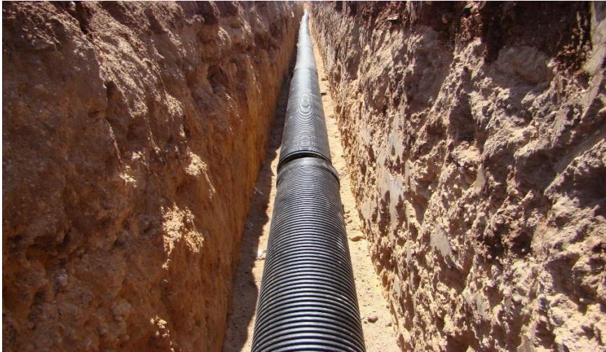
Figure VI-4: Pose de canalisation
