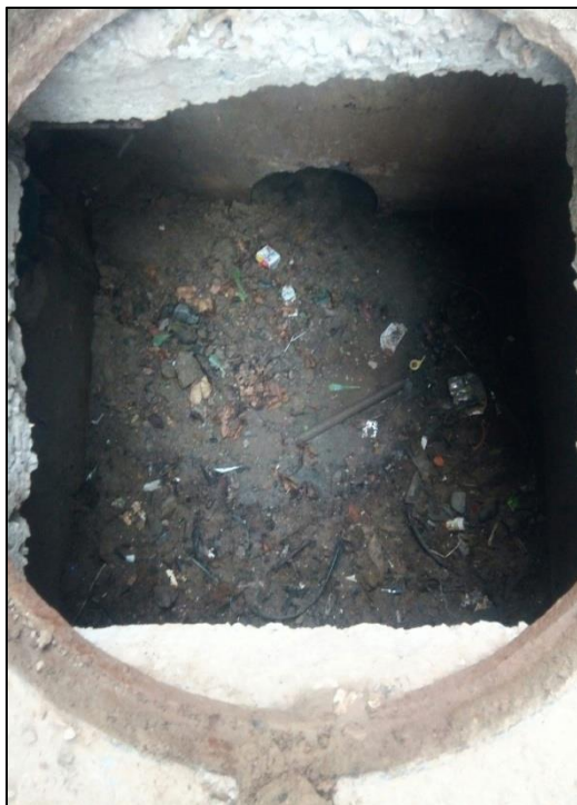
Figure III.4 Deux regards avec sédimentation des déchets solides.
