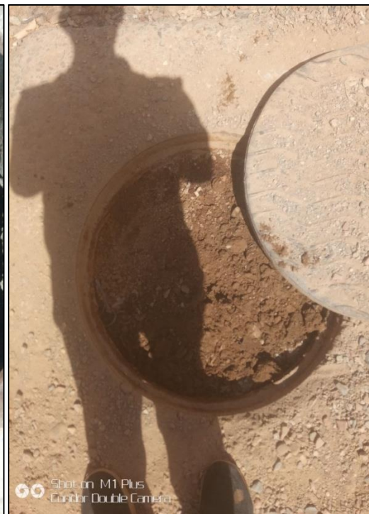
Figure III.4 Deux regards avec sédimentation des déchets solides.
