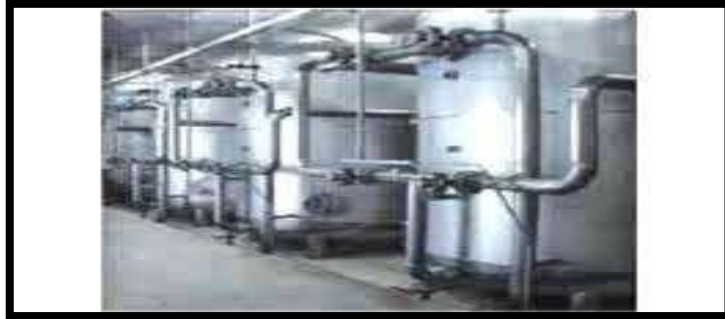
Figure III.13 Filtre charbon actif
