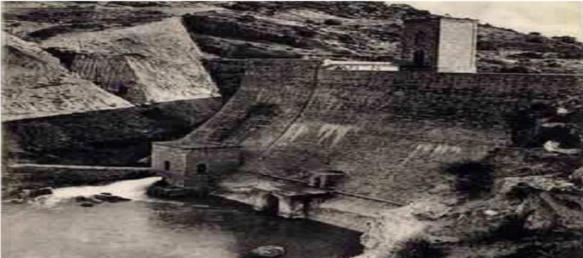
**Figure I.2 :** Barrage de Cheurfa, après travaux : nouvel appui Rive Droite vers l'amont (D'après Luc et Boris ; 2011)
