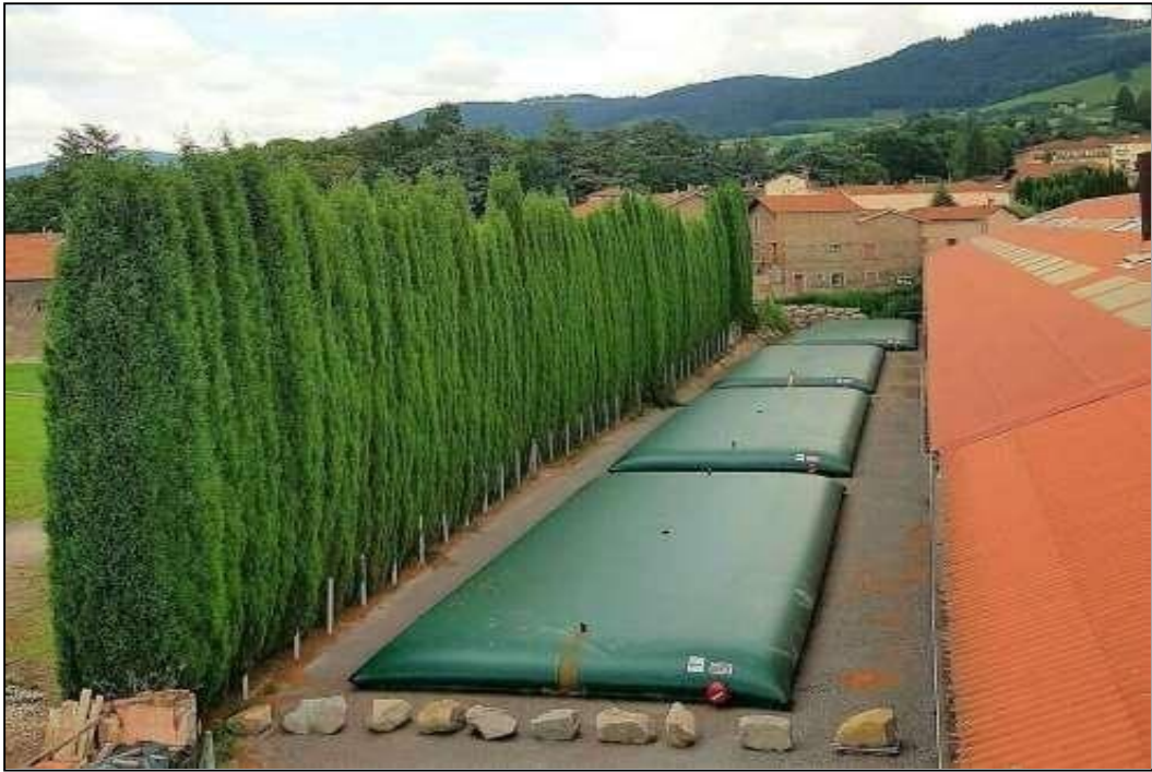
Figure VI- 19: Réservoir cuve et citerne souple pour l'eau brute.
