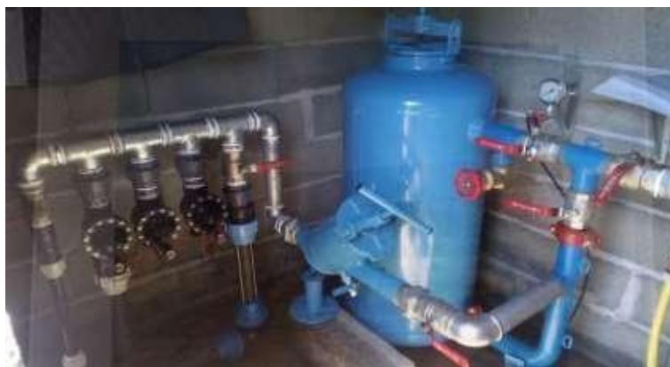
Figure VI- 2: Filtre à gravier
