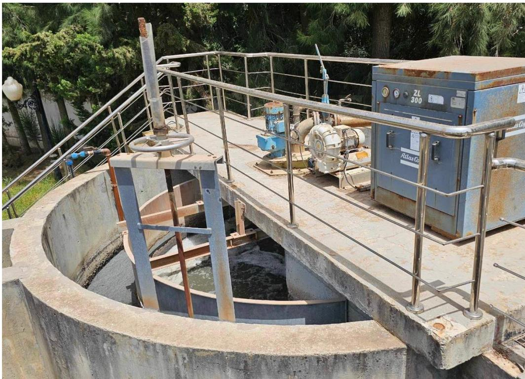
**Figure V.6** : Etape de dessablage/dégrillage (PP)
