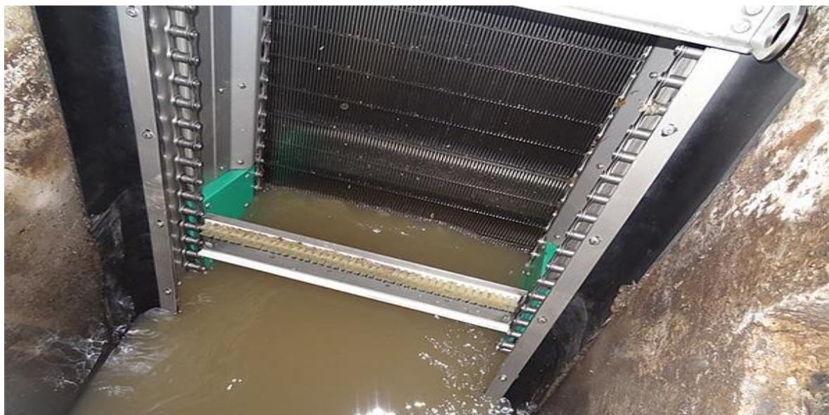
**Figure III.2 :** Dégrilleur automatique fin
