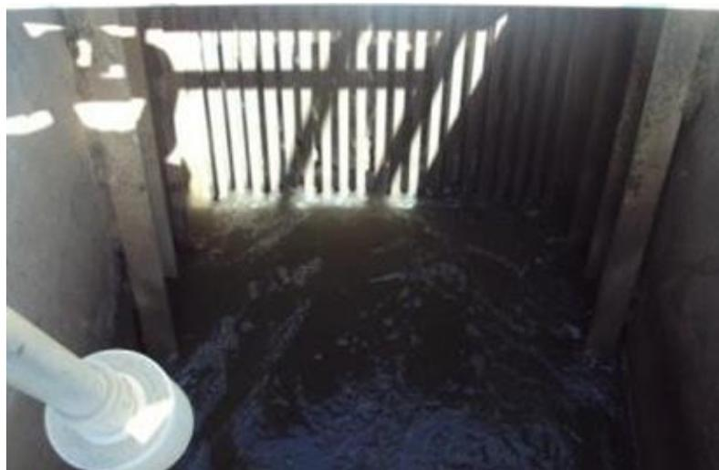
**Figure V.5 :** Photo illustrant le dégrilleur fin
