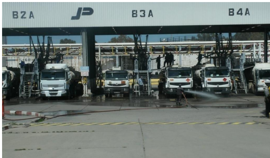
Figure 3: Poste de chargement des hydrocarbures (4)
