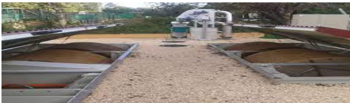
Figure.I.07 : disque biologique
