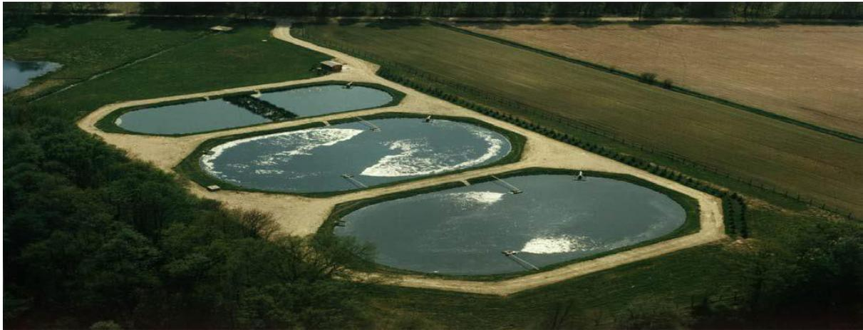
**Figure II.3 :** Système d'épuration par lagunes aérées. [13]
