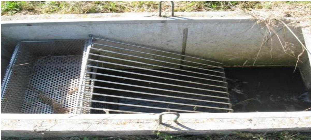
**Figure IV.1 :** dégrilleur automatique et manuel .
