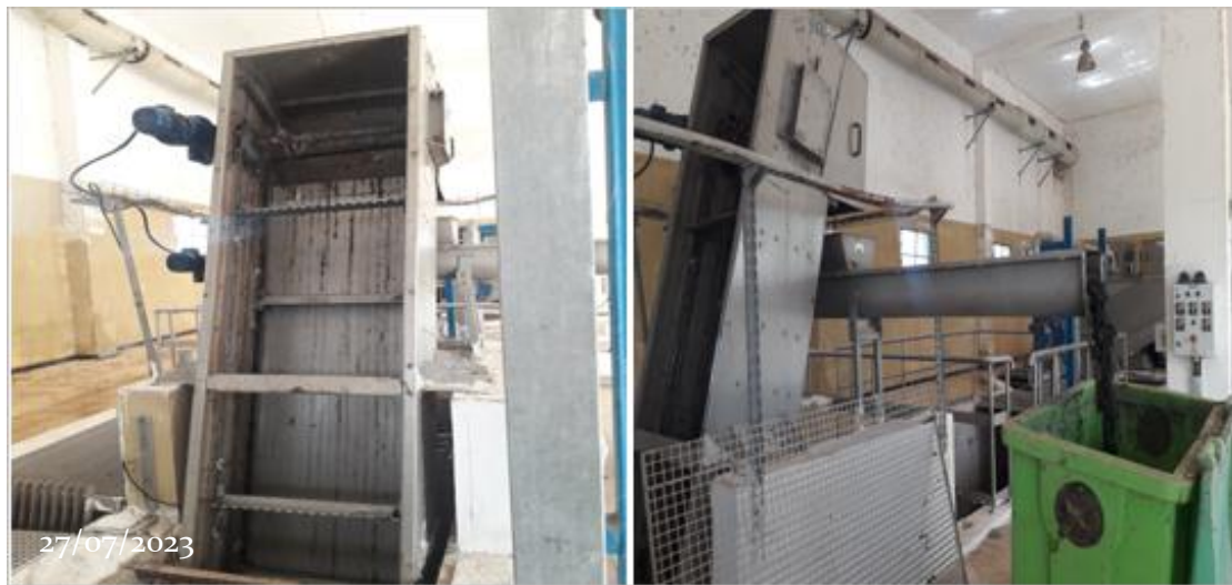
Figure IV.1 : Dégrilleur grossier.
