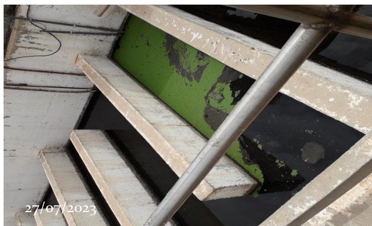
Figure IV.8 : Bassin de chloration.
