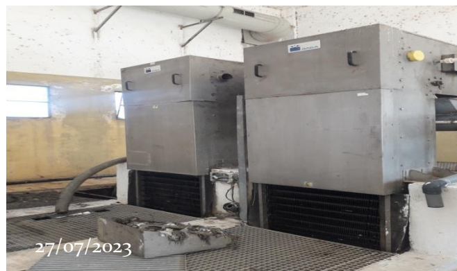
Figure IV.2 : Dégrilleurs fins.
