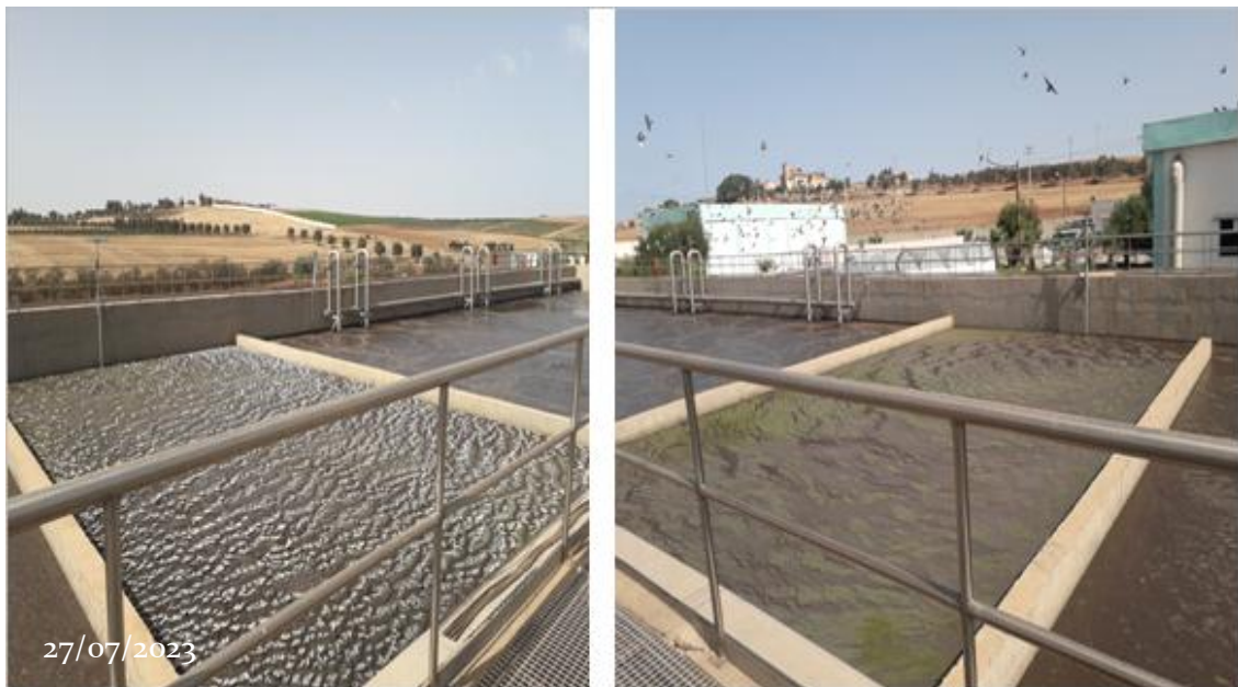
Figure IV.4 : Bassin d'aération.
