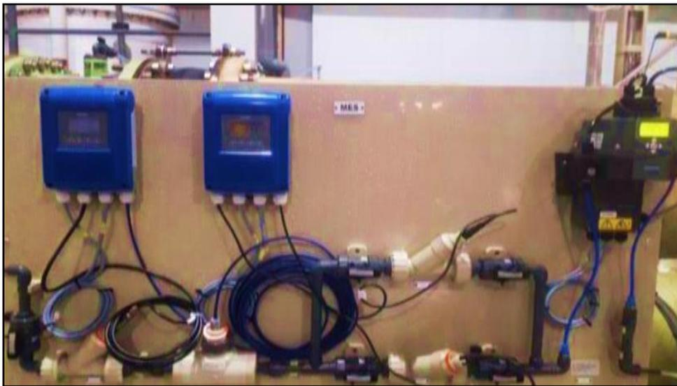
**Figure III. 17** - Les capteurs PH, T°C, Conductivité, turbidité et l'ORP
