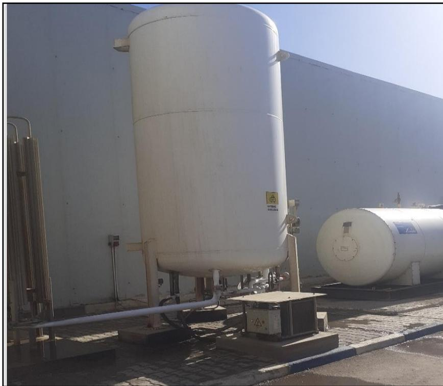
**Figure III.23** - Le système de stockage de CO<sub>2</sub>
