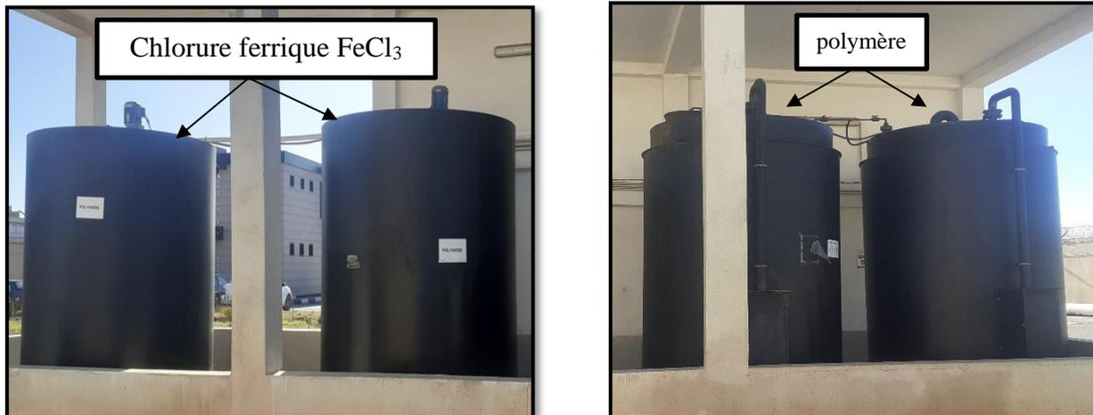
Figure III. 15 - les réservoirs de coagulation et floculation
