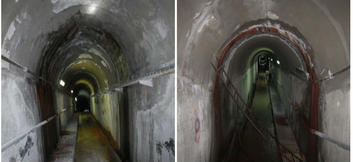
Figure II. 2: Galerie d'injection et de drainage (ISL, 2015)
