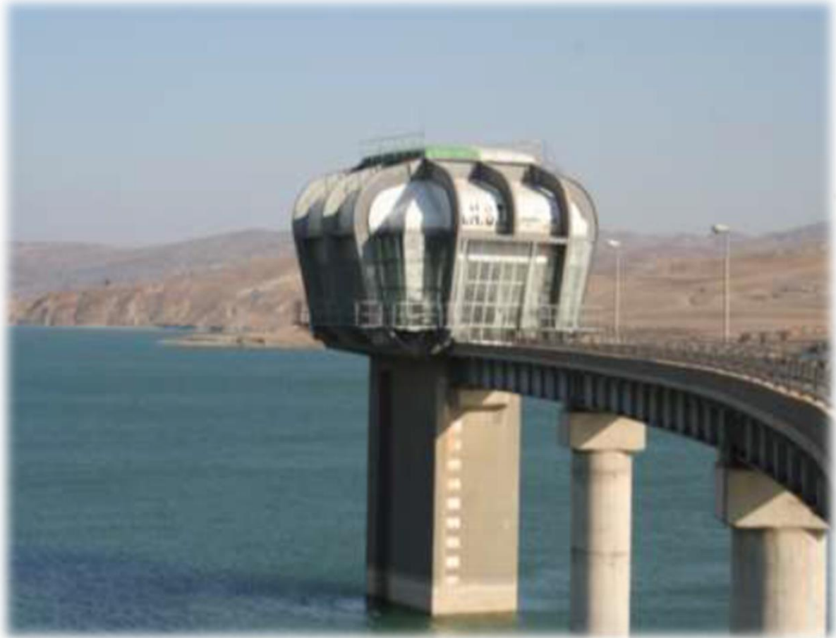
Figure I. 7: Tour de prise du barrage Kramis (ANBT, 2005)
