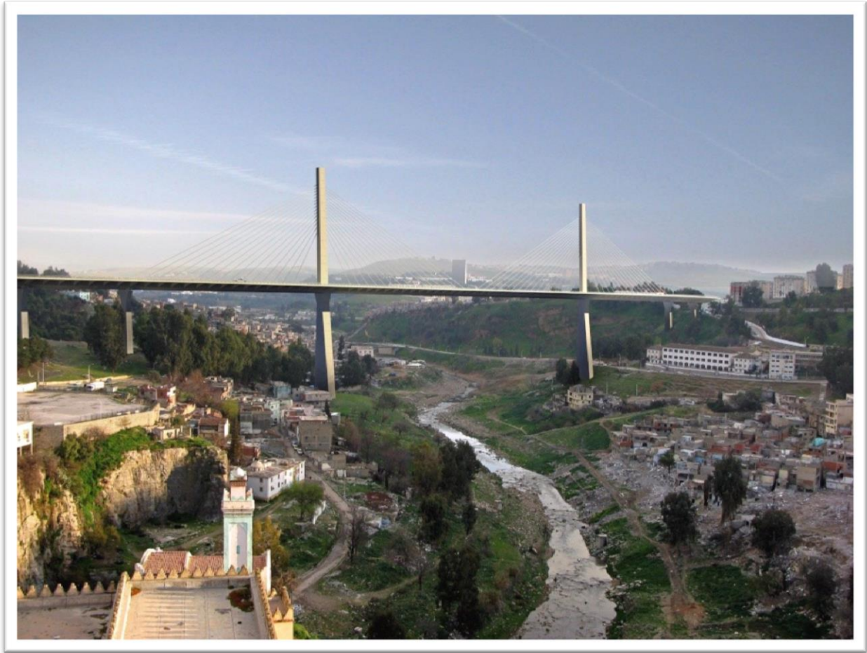
Figure n°IV 7 Pont de AIN EL BEY sur RHUMEL
