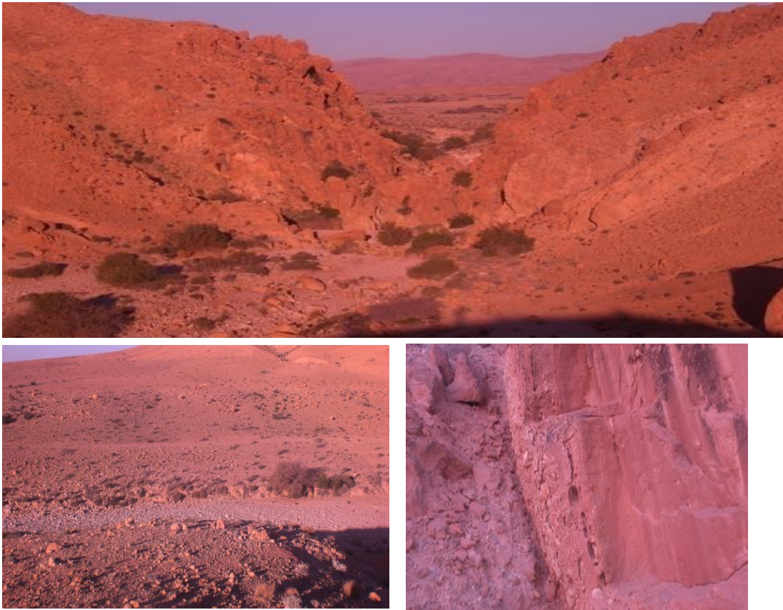
Figure II.1 Vues des rives et de lit d'oued de Maghraoua (Bureau d'Etudes Batna)
