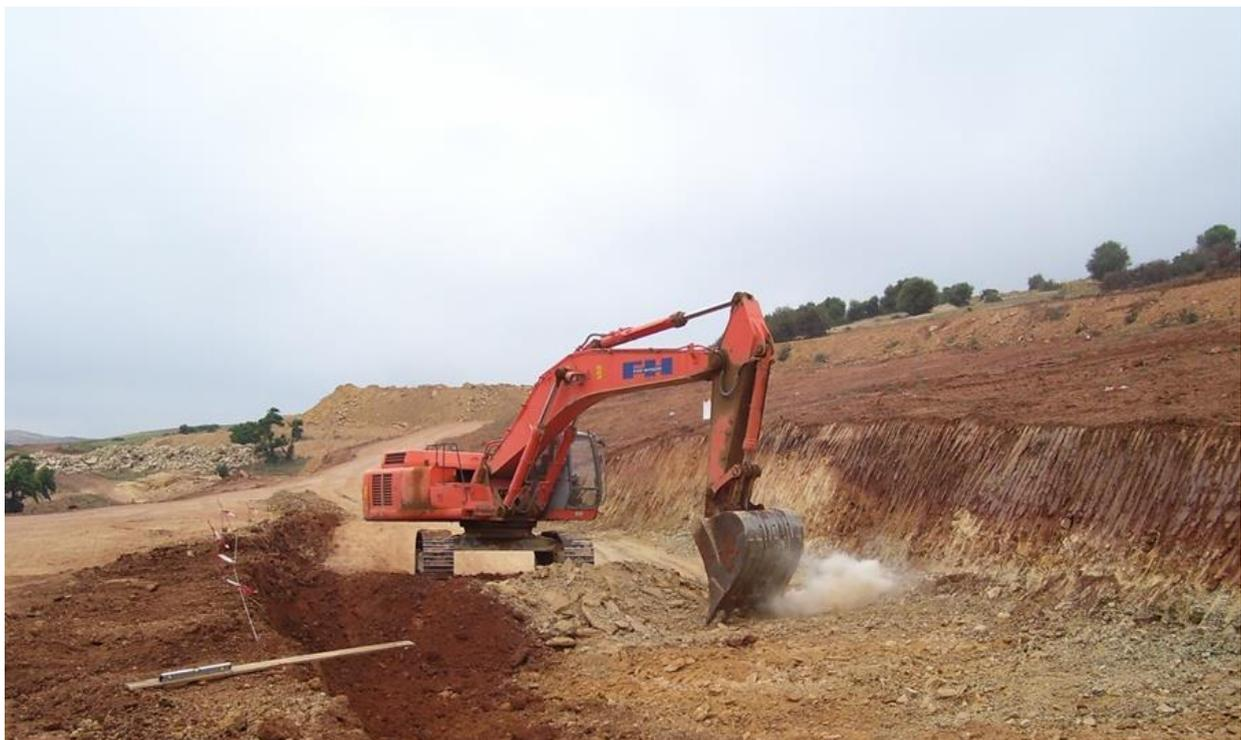
**Figure 4 :** pelle à chenilles avec godet à position rétro.
