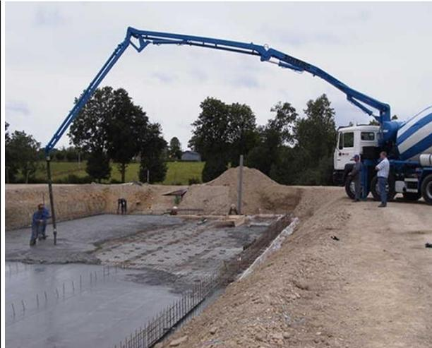
**Figure 6 :** pompe à béton.
