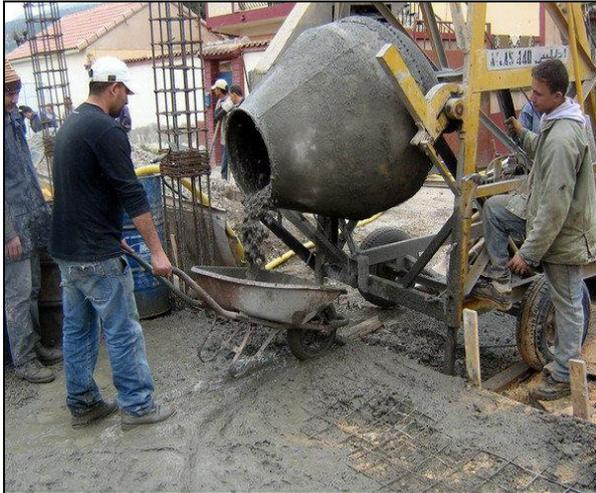
**Figure 5 :** bétonnière en cours de fonctionnement.
