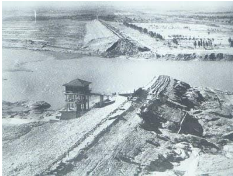
Figure 03 : Le barrage de Banqiao après la rupture. (International Rivers, 2015)
