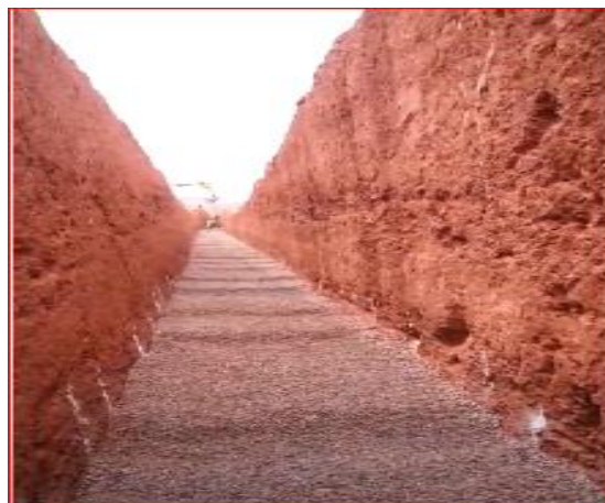
Figure VII.2: Pose du lit de sable.
