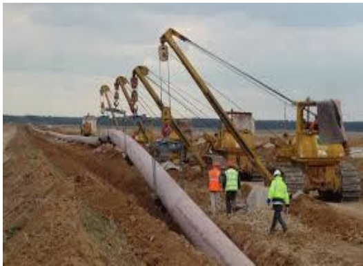
Figure VII.3: Pose des conduites.
