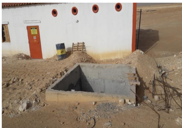
Figure VII.3 : Réalisation d'un regard de vanne. (Photo COSIDER).
