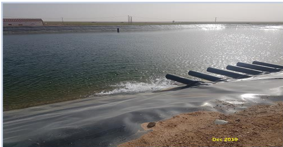
Figure IV.5 : bassin d'irrigation en géo-membrane (20000 m 3 ).
