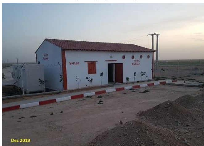
Figure VII.2 : Station de pompage de l'unité 01 (photo COSIDER).
